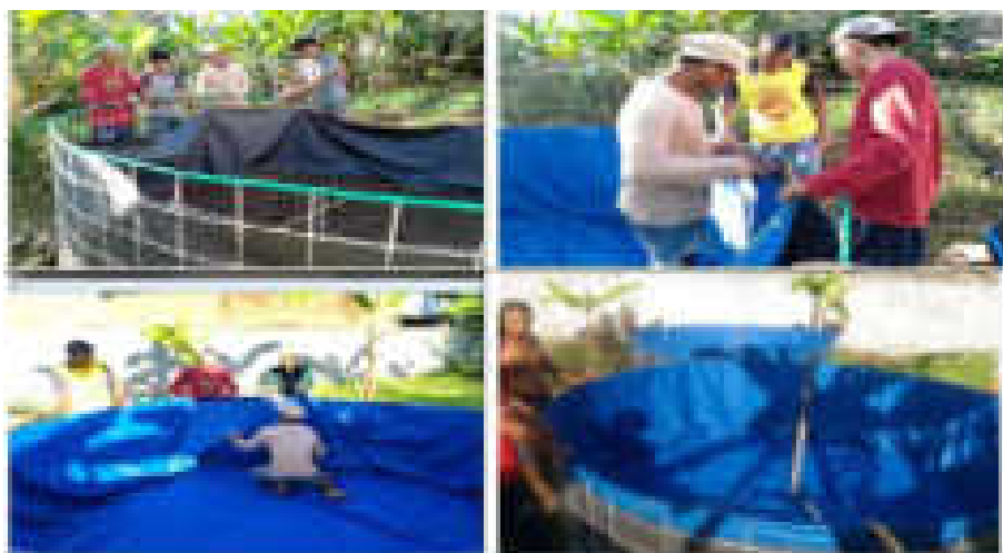
Gambar 1. Pemasangan kolam terpal
